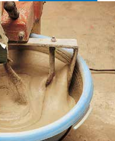
Mezclado de Planiseal 88 gris con agua
