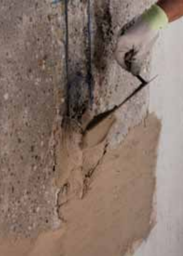
Aplicación con paleta de Planitop Rasa & Ripara
