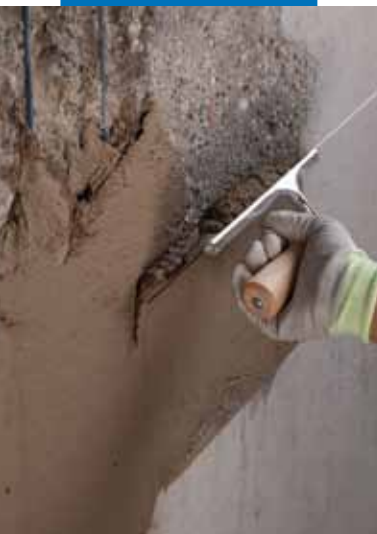
Aplicación con llana de Planitop Rasa & Ripara
